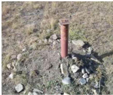
Рис. 1. Загальний вид ґрунтового репера
