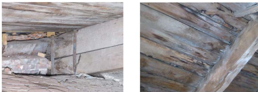
Рис.7. Сліди від систематичного зволоження деревини
