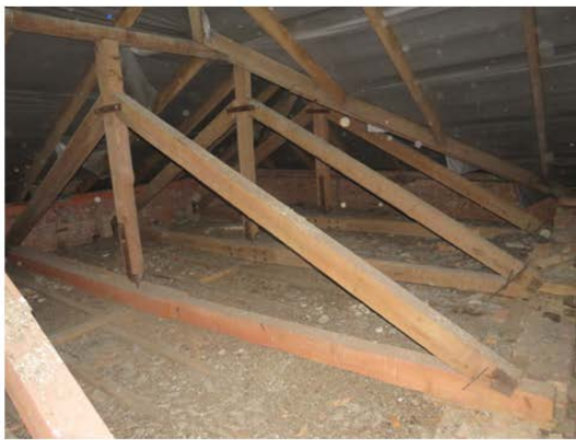
Рис.4. Загальний вигляд трикутних ферм типу 4
