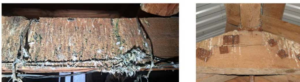
Рис.9. Загальний вигляд трикутних ферм типу 4
