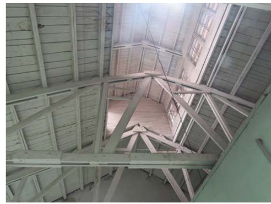
Рис.4. Загальний вигляд трикутних ферм типу 4
