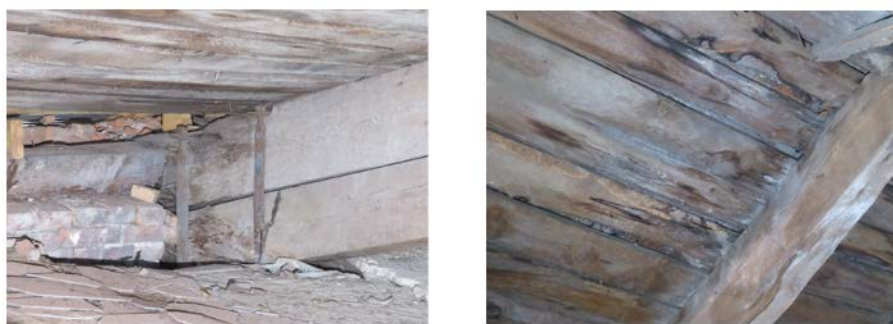
Рис.7. Сліди від систематичного зволоження деревини
