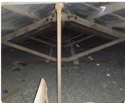
Рис.3. Загальний вигляд трикутних ферм типу 3
