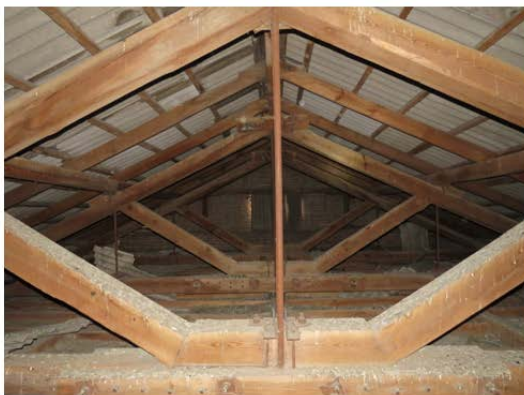
Рис.2. Загальний вигляд трикутних ферм типу 2
