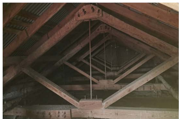
Рис.2. Загальний вигляд трикутних ферм типу 2
