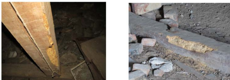
Рис.8. Ураження деревини жуками-деревооточцями
