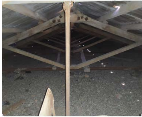
Рис.3. Загальний вигляд трикутних ферм типу 3
