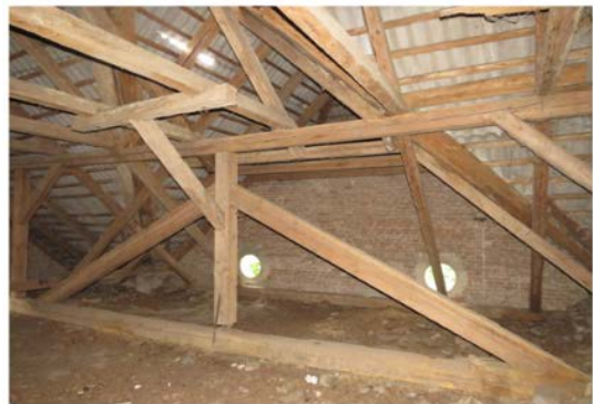
Рис.1. Загальний вигляд прямокутних дерев'яних ферм типу 1
