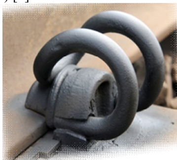
Рис. 1. Клема КП-5 проміжного скріплення типу КПП-5
