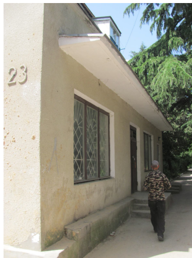
Рис. 1. Перепрофилируемое здание в г. Алуште
