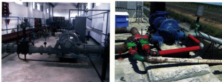
Рис. 2 – Види насосних станцій: а – електрична станція постійного розміщення; б – електрична станція тимчасового розміщення
