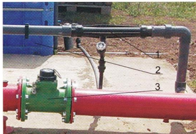
Рис. 4 – Інжектор «Вентурі»: 1 – інжектор; 2 – місткість для розчину, 3 – лічильник води
