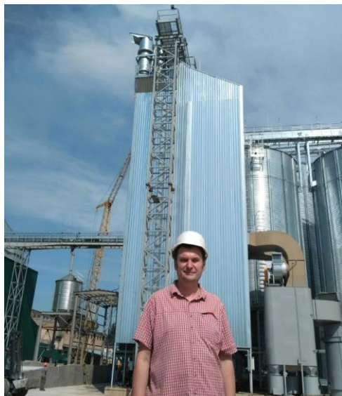
Рис. 3 – Монтаж зерносушарки BRICE-BAKER SCN-18/48
