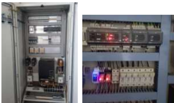
Рисунок 3 – Електрична шафа керування екструдером з використанням промислового контролера та реалізація шлюза RS485/WiFi
