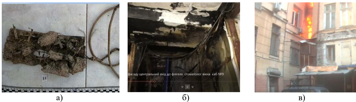
Рисунок 1– Наслідки аварійного режиму роботи електричного подовжувача:
