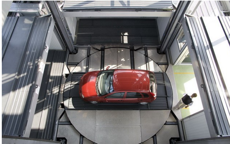
Рис. 3- Платформа підйомно-спускового механізму із завантаженим автомобілем [5]
