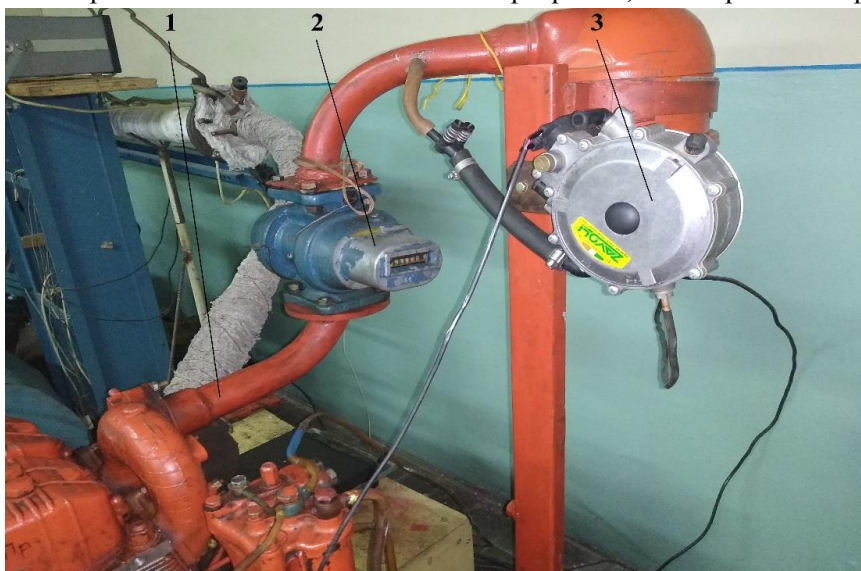
1 – впускний тракт; 2 – газовий лічильник; 3 – газовий редуктор
