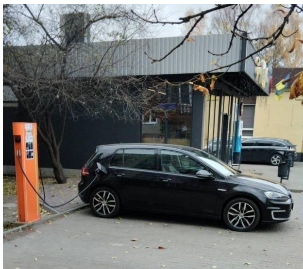
Рисунок 4 – Зарядна станція на стоянці біля торговельного закладу
