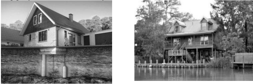
Рис. 4. Фундамент із залізобетонних паль
