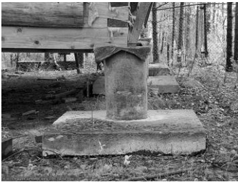
Рис. 2. Влаштування фундаменту з частковою заміною ґрунту з опорами-колонами
