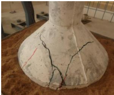
Рис. 3. Схема тріщин зруйнованої залізобетонної моделі КФ-О
