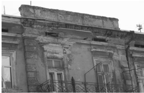
Рис.3. Карниз будинку по вулиці Серова 37
