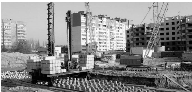
Рис. 2. Вдавлюючий пристрій ВП-250
