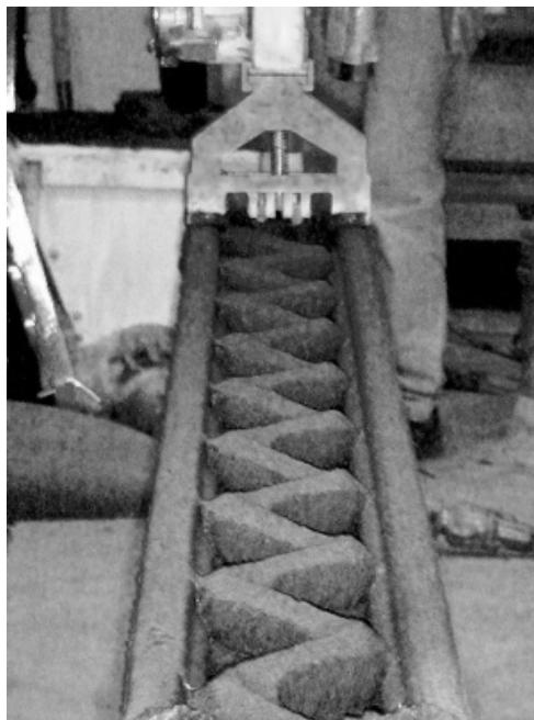
Рис. 2. Друк стіни – механізм із форсунками робить послідовні проходи з накладанням нових шарів бетону
