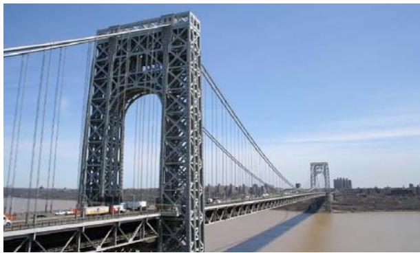
Рис. 1. Міст Г. Вашингтона через р.. Гудзон в Нью-Йорку
