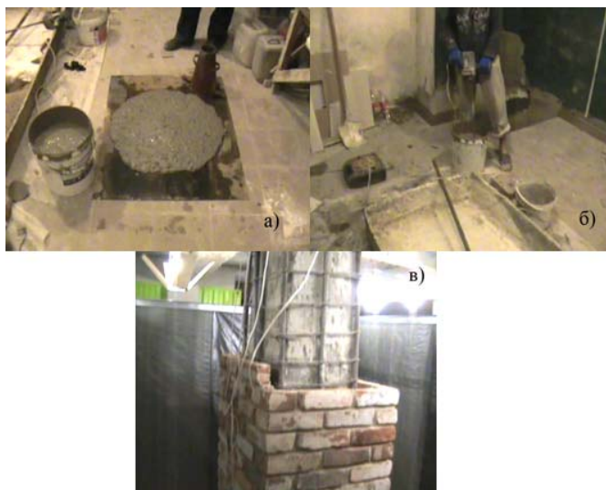
Рис. 2. Ремонт колонны с применением СУБ: а) – определение расплыва конуса для СУБ; б) – приготовление самоуплотняющейся бетонной смеси; в) – ремонтируемая колонна с несъемной опалубкой в виде стенки из кирпича
