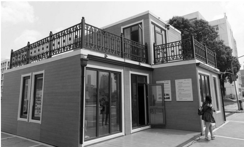
Рис. 7. Загальний вигляд будинку зведеного компанією ZhuoDa
