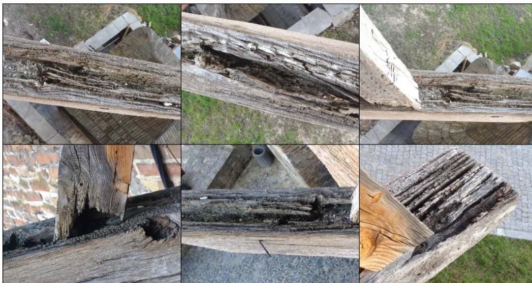
Рис.3. Біологічне руйнування та гниття дерев'яних консолей
