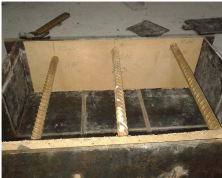
Рис. 2 Фіксація положення арматури перед бетонуванням
