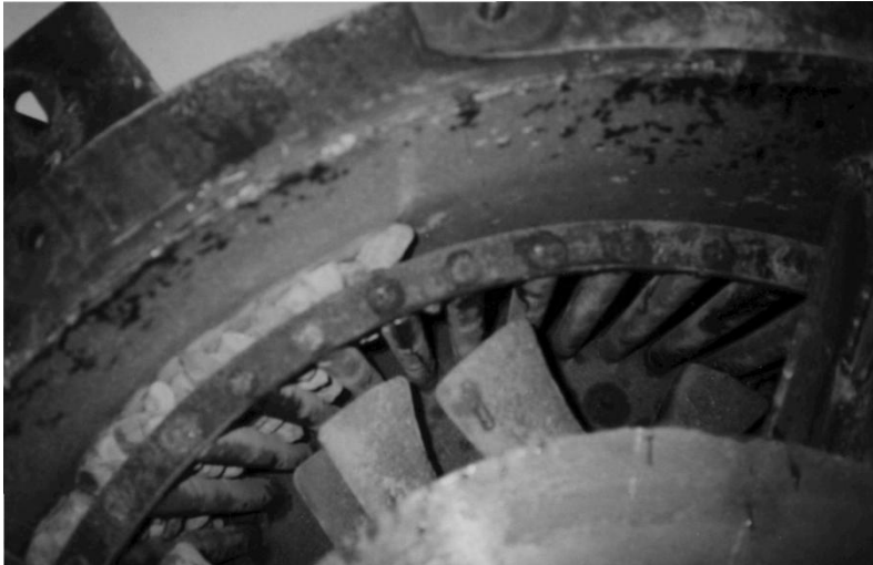
Рис. 3. Застрявшие куски щебня между решеткой и корпусом дробилки
