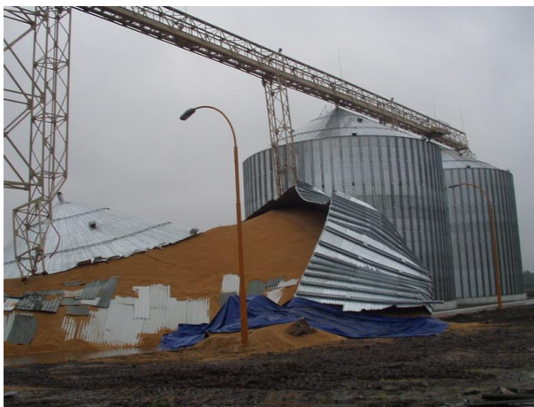
Рис. 2. Недостаточная несущая способность силосов при действии эксплуатационных нагрузок
