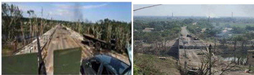
Рис. 4. Зруйнований міст між Сіверськодонецьком та Лисичанськом
