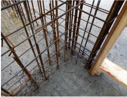
Рис. 2. Підготовлені до закриття опалубки стіни
