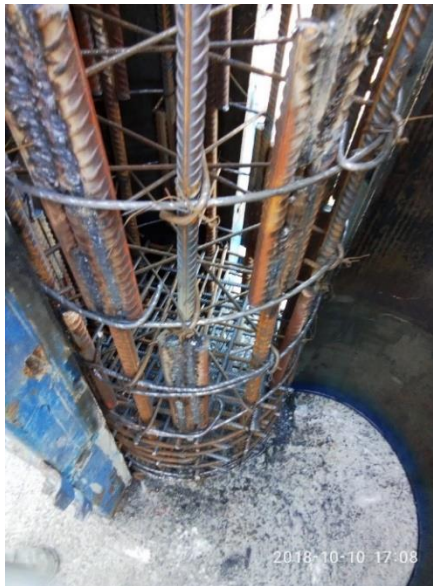
Рис. 3. Опалубка колони, розкрита перед бетонуванням
