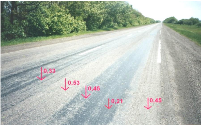
Рис. 1. Результати вимірювання коефіцієнта зчеплення на автомобільній дорозі II категорії в Харківській області
