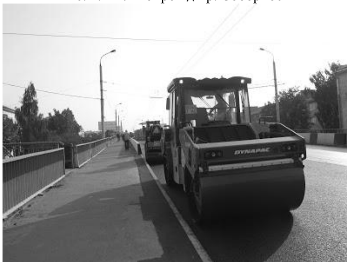
Рис. 2. Завершення ремонтних робіт шляхопроводу пр. Соборності
