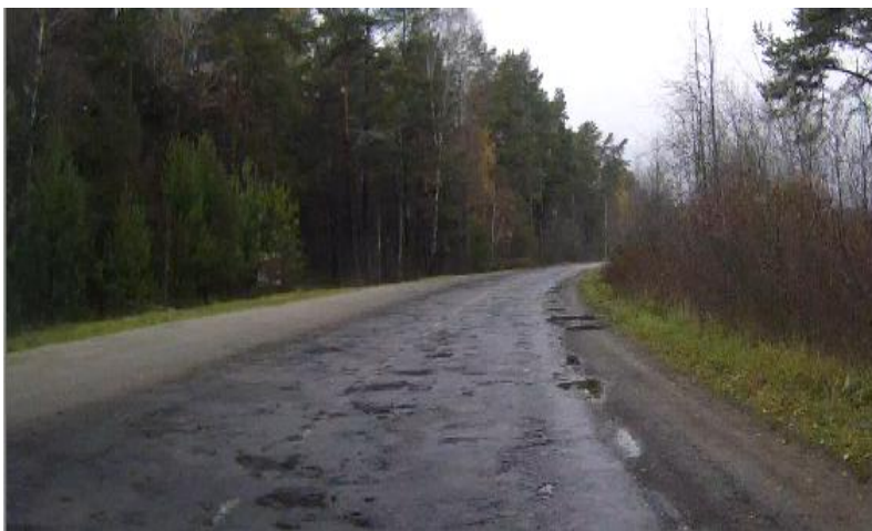
Рис.2. Стан покриття а/д Т-03-02 на ПК 0+00 – ПК 53+90 та ПК 110+38 – ПК 112+52 (вибої, викришування та злущування).
