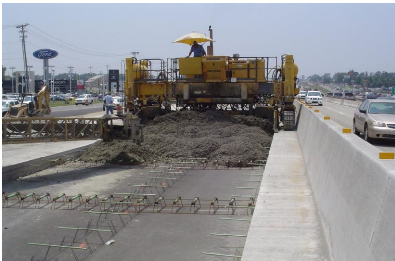
Рис.1 Влаштування покриття із сталефіробетону.
