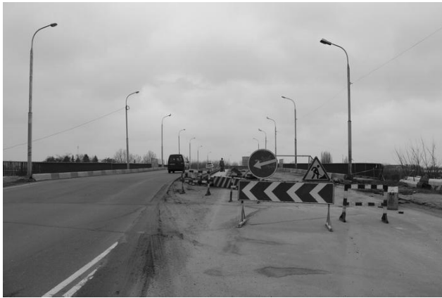
Рис. 4. Проведення ремонтних роботи шляхопроводу по вул. Рівненській
