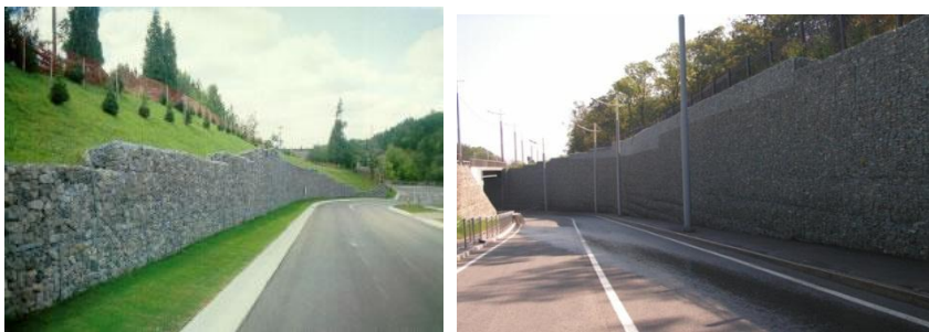
Рисунок 1 – Приклад використання габіонних підпірних стін
