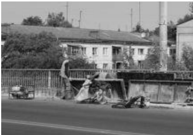
Рис. 5. Підготовка до ремонту шляхопроводу по вул. Гордіюк
