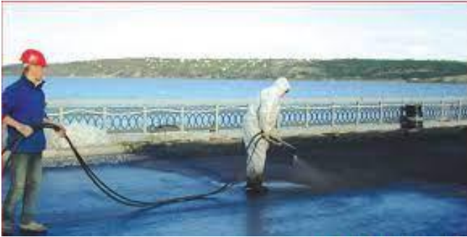
Рис. 7. Нанесення гідроізоляційного матеріалу FLEXIGUM-HP
