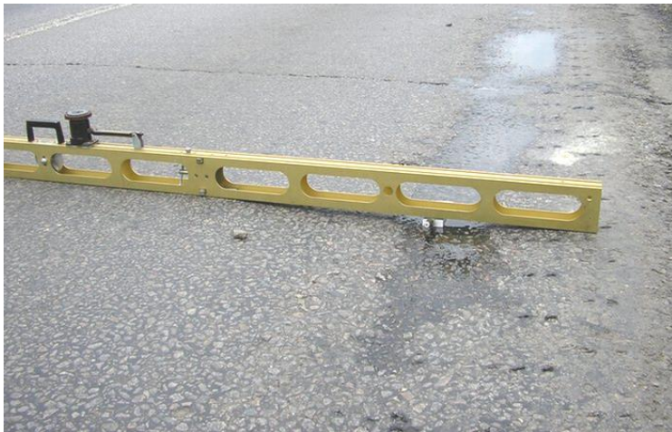
Рис. 2. Колійність на автомобільній дорозі II категорії, фото зроблене через 7 годин після закінчення дощу
