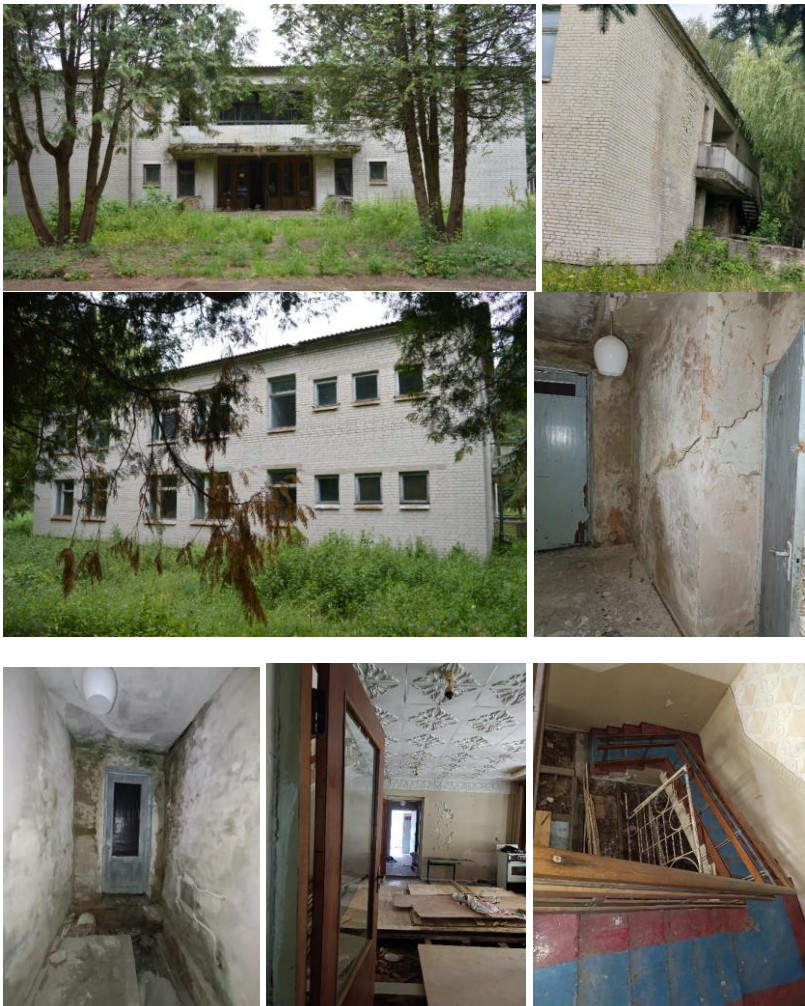
Рис. 3. Фото фактичного стану будівлі №2 ззовні та всередині
