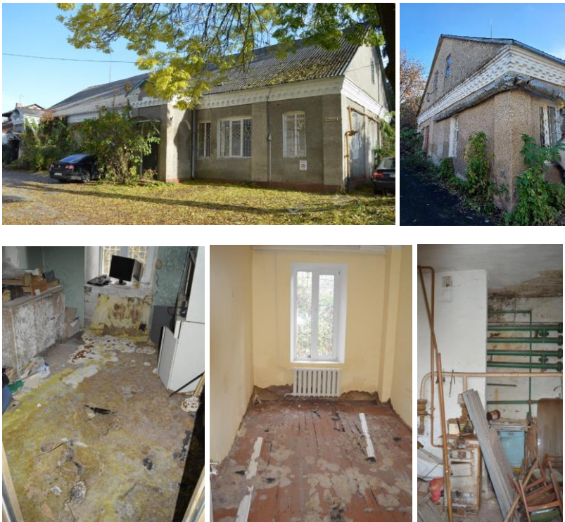
Рис.1. Фото фактичного стану будівлі №1 зовні та всередині
