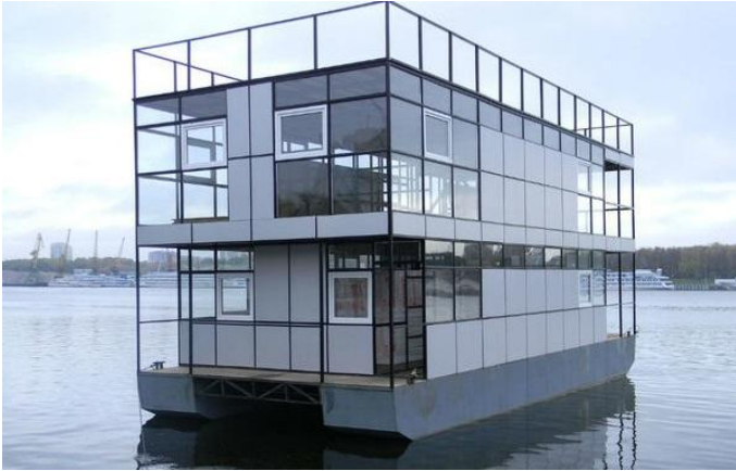
Рис. 6. Будівля на металевому понтоні
