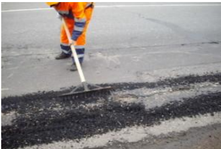
Рис. 3. Усунення дефектів покриття
