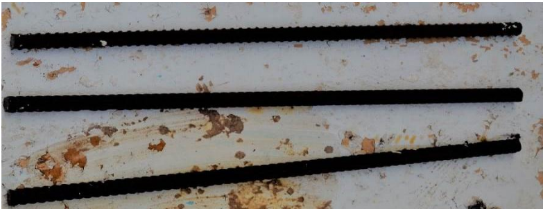
Рис. 1. Вигляд арматури: а) чистих стержнів; б) покриті консервант-модифікатором перетворювачем іржі «Контраст»
