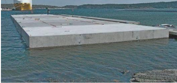
Рис. 3. Залізобетонні понтони, з'єднані між собою
