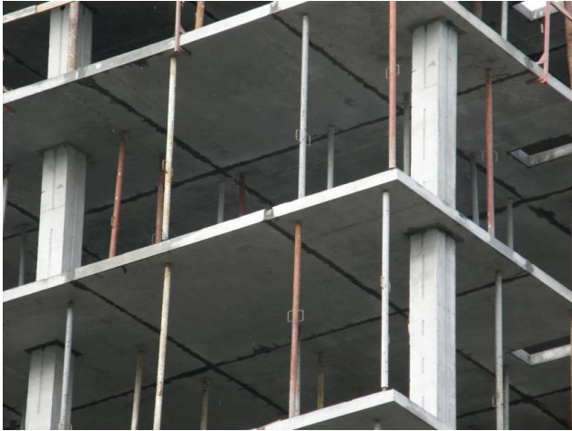
Рис. 1. Вигляд збірно-монолітного безкапітельно-безбалкового каркасу
