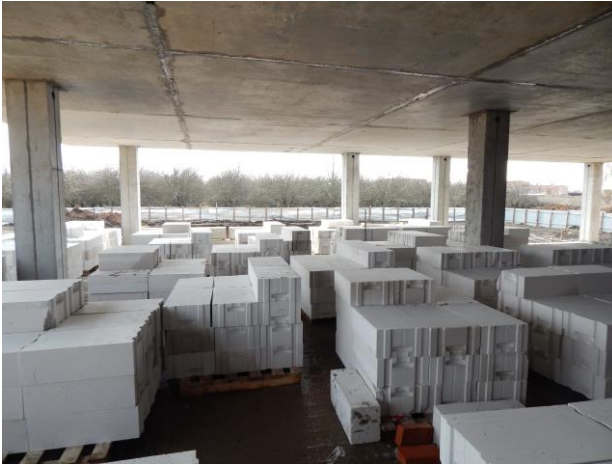
Рис. 5. Вигляд навантаженого перекриття
