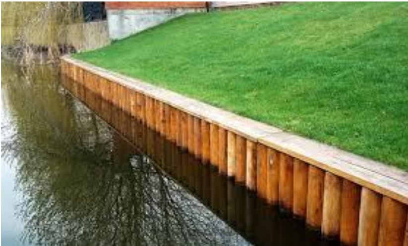
Рис.4. Берегоукріплення водойми дерев'яними палями
