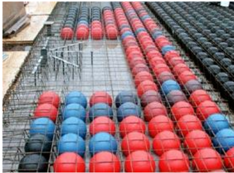
Рис. 4. Фрагмент укладання на поверхню опалубочного настилу арматурних каркасів з поліетиленовими порожніми кулями.
