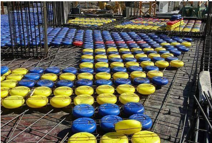
Рис. 6. Приклад розташування порожниноутворювачів.
