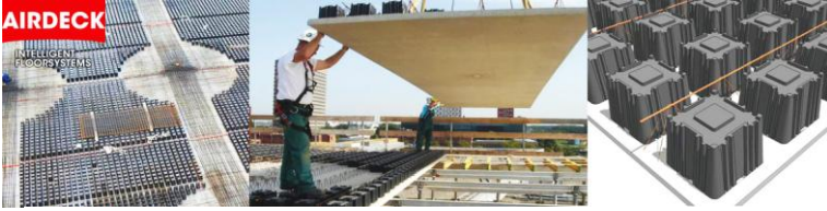
Рис. 1 Полегшені залізобетонні перекриття за технологією Airdeck.
