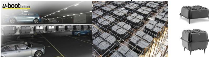
Рис. 4 Перекриття за технологією U-boot beton
