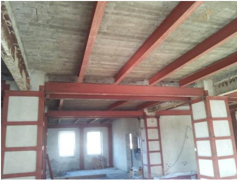
Рис.4. Влаштування комбінованого сталезалізобетонного перекриття
