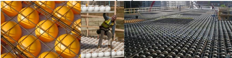
Рис. 3 Плита по типу BubbleDeck
