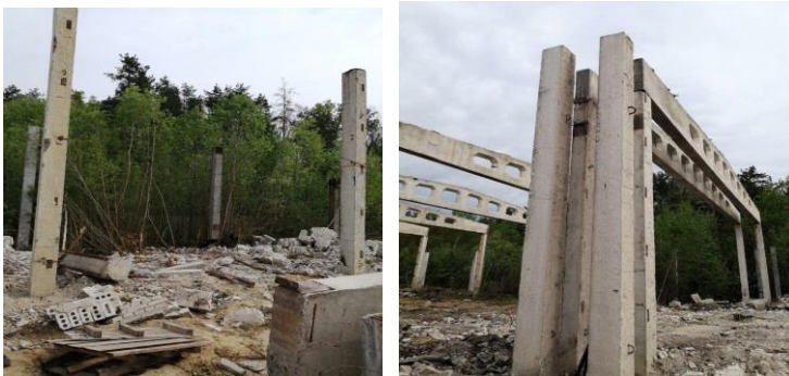
Рис. 1. Елементи каркасу в стадії демонтажу
