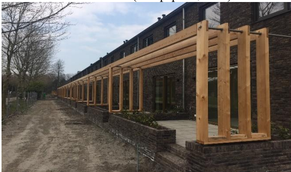
Рис. 5. Несучі конструкції альтанок з використанням LVL-композитів
