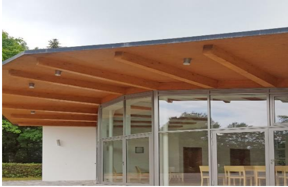
Рис. 3. Елементи покрівлі з використанням LVL-композитів
