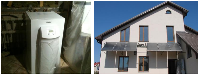
Рис. 4. Практичний досвід: тепловий насос типу «вода-вода» та сонячні колектори для опалення і гарячого водопостачання готельно-ресторанного комплексу (Волинська область)
