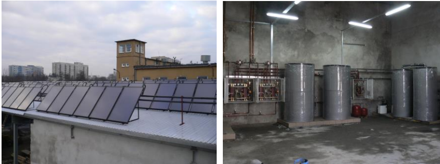
Ри. 2. Практичний досвід: сонячні колектори для систем опалення та гарячого водопостачання Новотроїцького масло-сирзаводу (Херсонська область)
