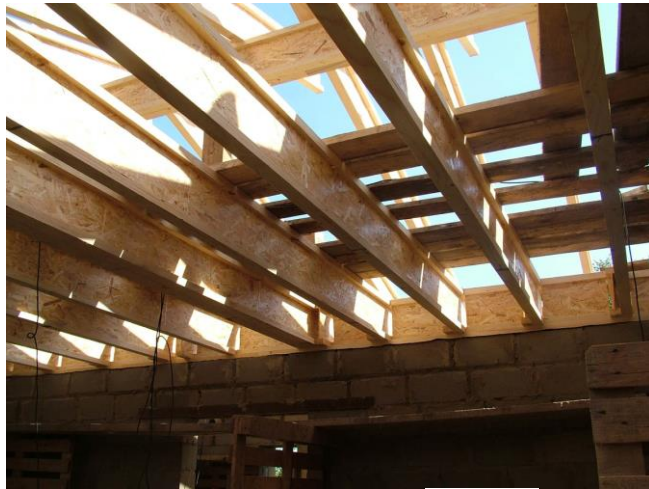
Рис. 2. Змонтовані балки перекриття
