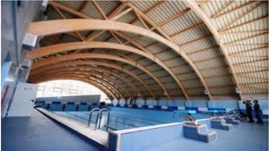
Рис.4. Басейн з несучими конструкціями з деревини
