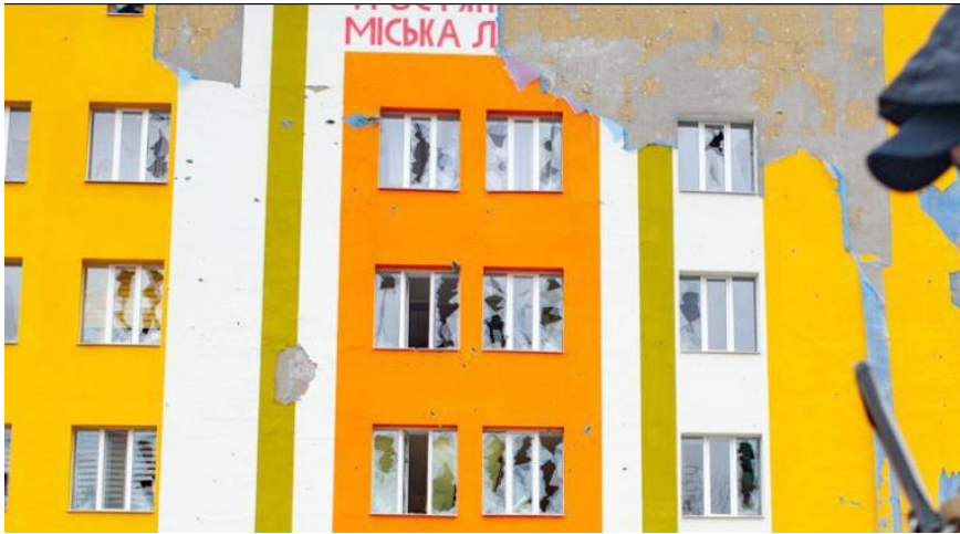
Рис. 4. Будівля, утеплена базальтовою ватою
