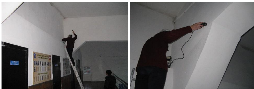
Рис. 1. Вимірювання захисного шару бетону приладом ІЗС-10Н
