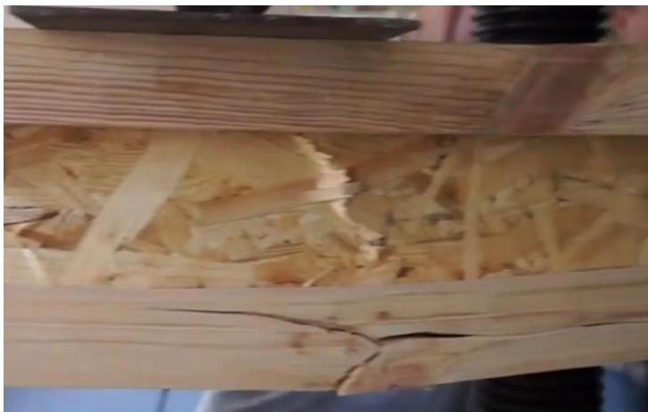
Рис. 5. Вигляд руйнування балки
