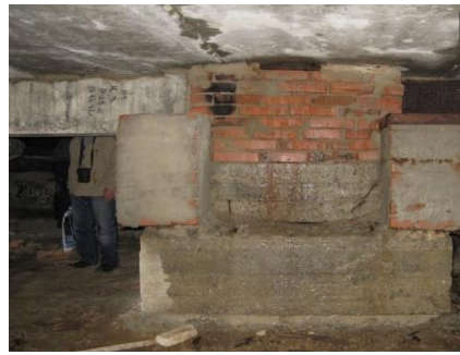
Рис. 8. Обпирання залізобетонної балки
