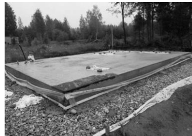
Рис. 3. Влаштування монолітної плаваючої плити
