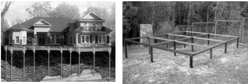
Рис. 5. Фундамент на гвинтових палях
