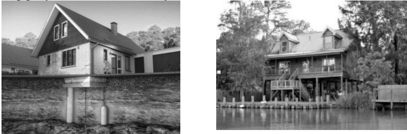
Рис. 4. Фундамент із залізобетонних паль
