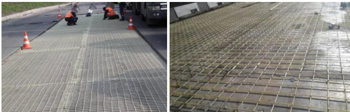
Рис. 2. Монтаж армуючого прошарку у вигляді композитних сіток в нижньому шарі пакету асфальтобетонних шарів
