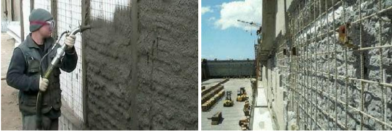
Рис. 5. Композитні сітки в торкрет-оболонках
