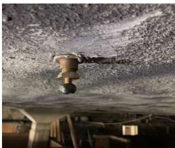
Рис. 4. Підготовлений зразок для оцінки адгезійної міцності торкретбетону
