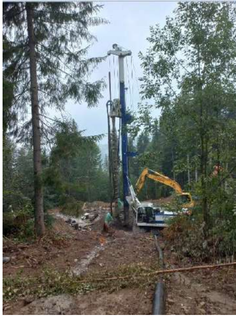
Рис. 1 Влаштування буронабивних паль по технології CFA
