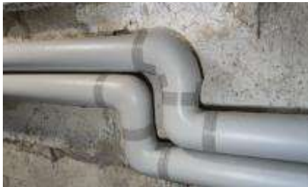
Рис. 6. Механічний захист утеплювача
