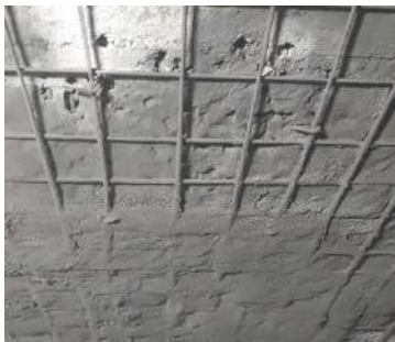
Рис. 2. Загальний вигляд поверхні при нанесенні шару торкретбетону
