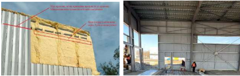
Рис. 2. Фото конструкції одношарової системи профільованого листа LPA900 з внутрішнім волокнистим утеплювачем INF 100 мм.
