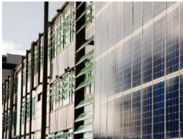
Рис. 2. Фотоелектрична система, вбудована в фасад
