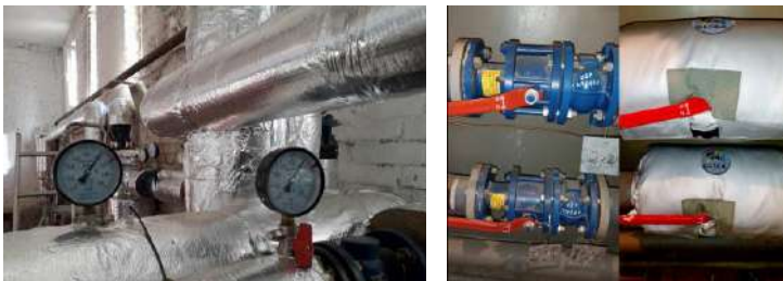
Рис. 4. Приклад якісного утеплення трубопроводів та фланцевої арматури
