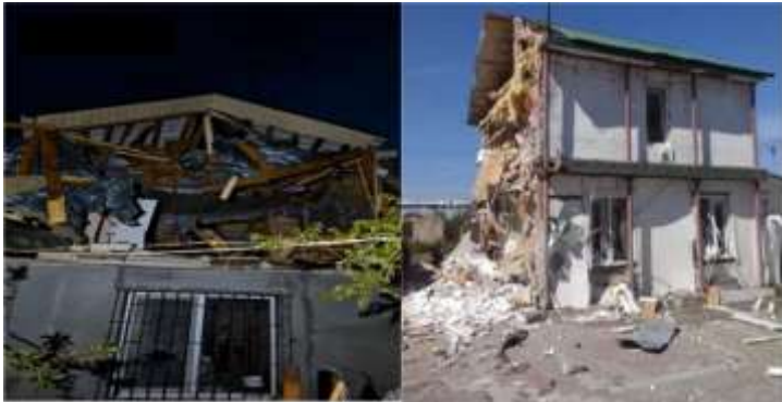
Рис. 1. Загальний вигляд пошкодженого будинку, що розглядається як об'єкт реконструкції та модернізації інженерного обладнання
