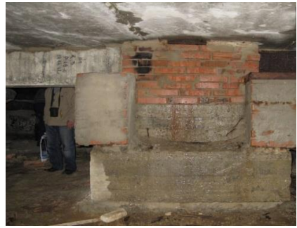
Рис. 8. Обпирання залізобетонної балки
