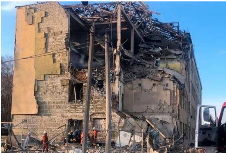
Рис. 7. Будівля, утеплена базальтовою ватою
