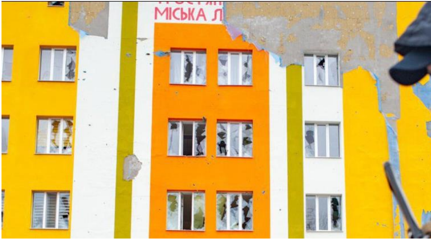
Рис. 4. Будівля, утеплена базальтовою ватою
