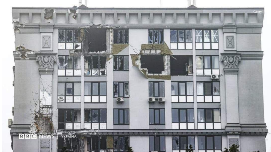
Рис. 3. Будівля, утеплена базальтовою ватою
