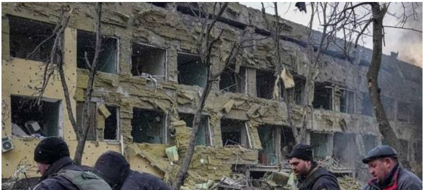
Рис. 5. Будівля пологового будинку, утеплена базальтовою ватою
