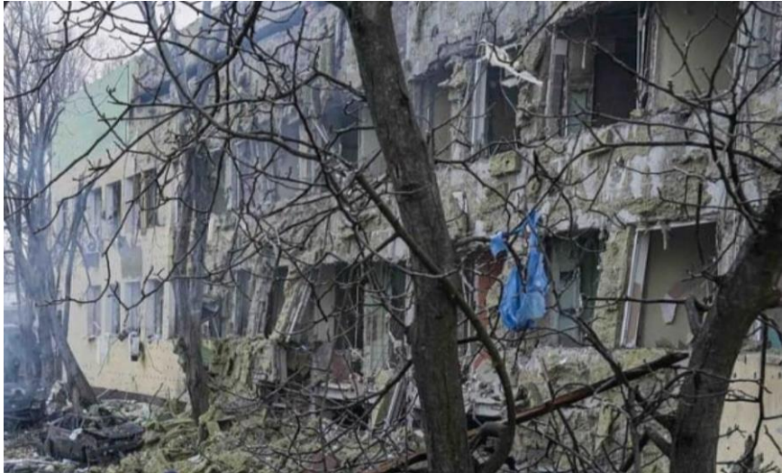
Рис. 6. Будівля пологового будинку, утеплена базальтовою ватою
