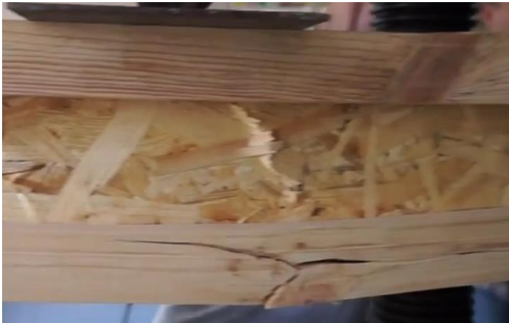
Рис. 5. Вигляд руйнування балки
