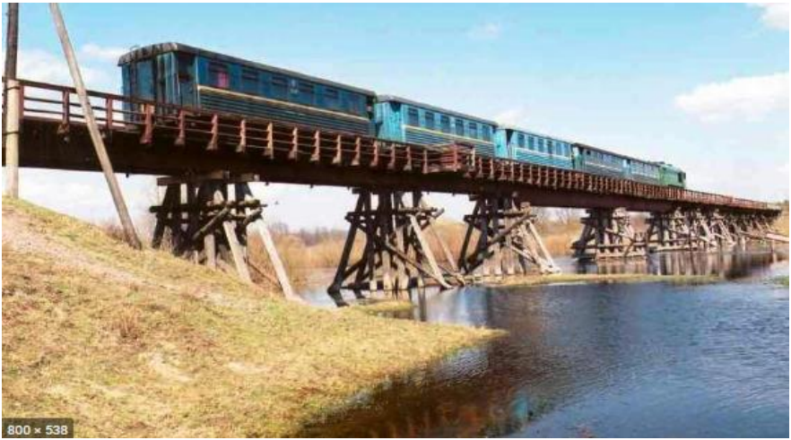
Рис. 2. Дерев'яний міст через річку Стир
