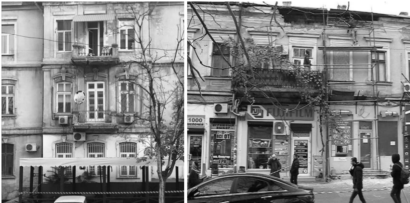
Рис.4. Обвалення балкону на перехресті вулиць Буніна і Канатна та ремонтні заходи старого будинку на розі Садової і Торгової вулиць
