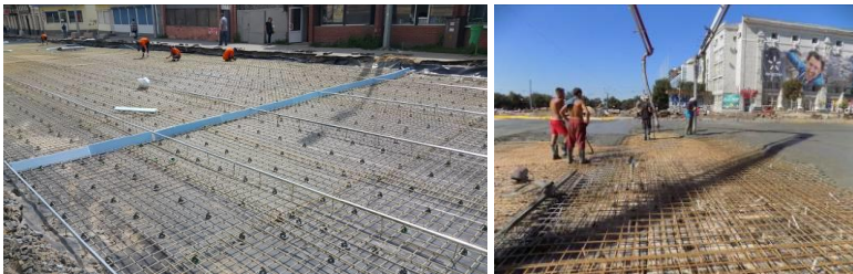
Рис. 3. Збір армокаркасу дорожньої цементобетонної плити основи по вул. Клочківська, м. Харків з композитних георешіток з влаштуванням термодеоформаційних швів із подальшим бетонуванням
