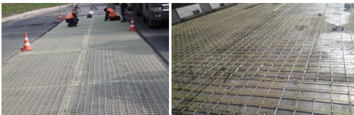
Рис. 2. Монтаж армуючого прошарку у вигляді композитних сіток в нижньому шарі пакету асфальтобетонних шарів
