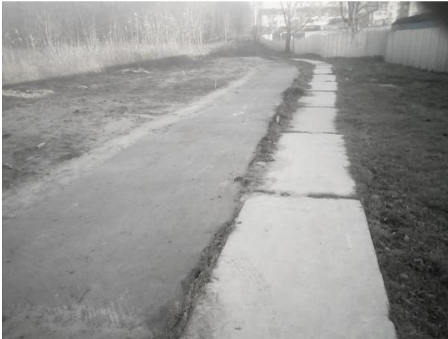
Рис. 4. Загальний вигляд влаштованої дослідної ділянки (ділянка зліва від ПАГ)
