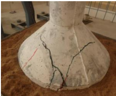
Рис. 3. Схема тріщин зруйнованої залізобетонної моделі КФ-О
