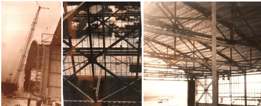
Рис. 1. Фотофіксація при будівництві ангара в м. Алмати (Казахстан)
