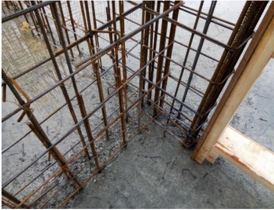
Рис. 2. Підготовлені до закриття опалубки стіни
