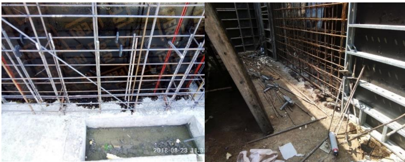
Рис. 1. Підготовлені до закриття опалубки стіни
