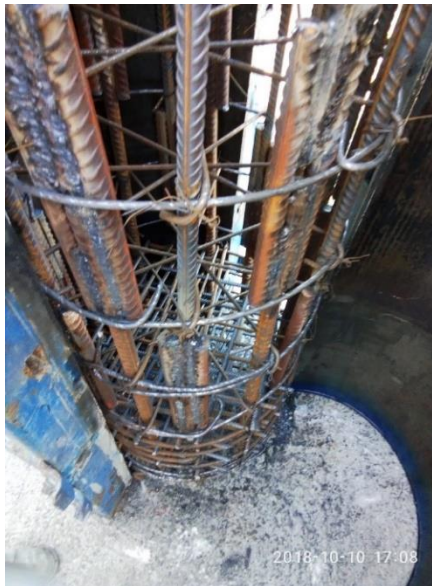
Рис. 3. Опалубка колони, розкрита перед бетонуванням
