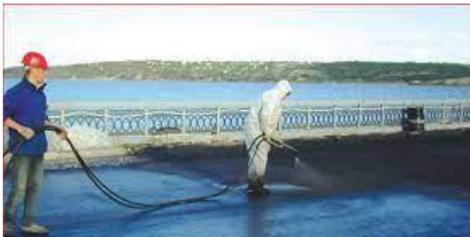
Рис. 7. Нанесення гідроізоляційного матеріалу FLEXIGUM-HP
