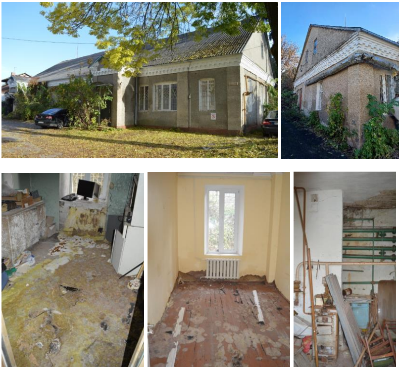
Рис.1. Фото фактичного стану будівлі №1 зовні та всередині
