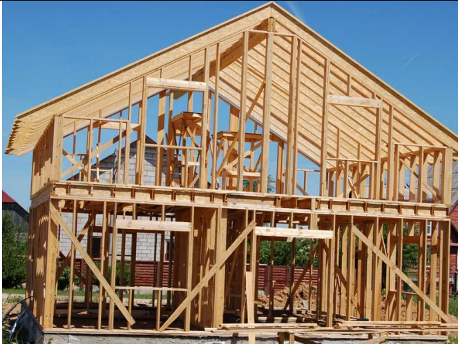
Рис. 3. Каркас будівлі з клеєної деревини
