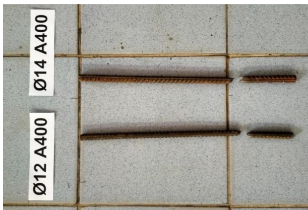
Рисунок 6 – Зруйновані стержні металеві арматури
