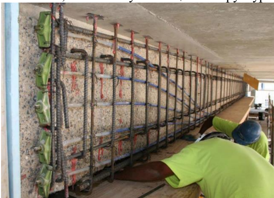
Рисунок 4 – Підсилення монолітних балок шляхопроводу за допомогою напружених канатів із подальшим обетонуванням («Reinforcing internal post-tensioning»)
