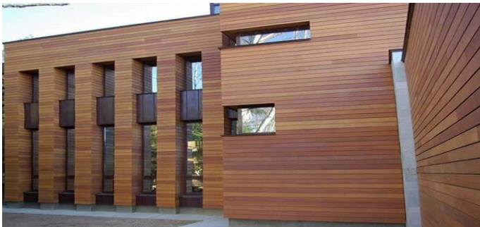
Рис. 3. Промислова будівля з використанням зовнішніх панелей, виготовлених на основі модифікованої деревини
