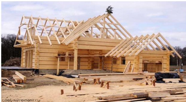
Рис. 1. Несучі конструкції будинків різного призначення з модифікованої деревини: а) покриття басейну; б) каркас одноповерхового житлового будинку
