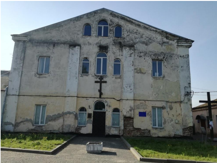
Рис. 3. Будівля монастиря бригідок
