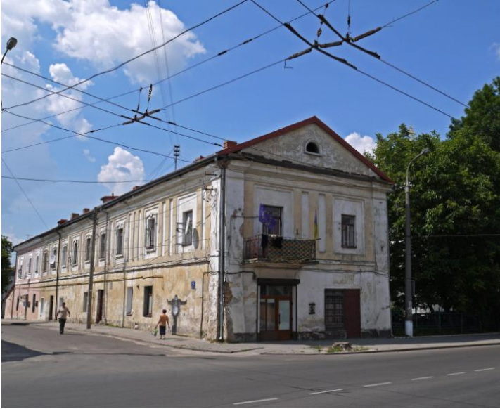
Рис. 2. Будівля монастиря Луцького Хрестовоздвиженського братства
