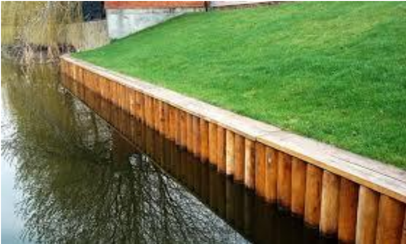
Рис.4. Берегоукріплення водойми дерев'яними палями
