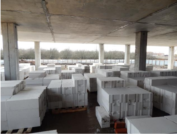
Рис. 5. Вигляд навантаженого перекриття
